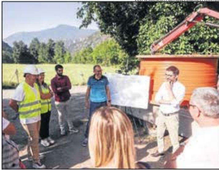
Puigneró en la visita a les obres per desplegar la fibra òptica.
