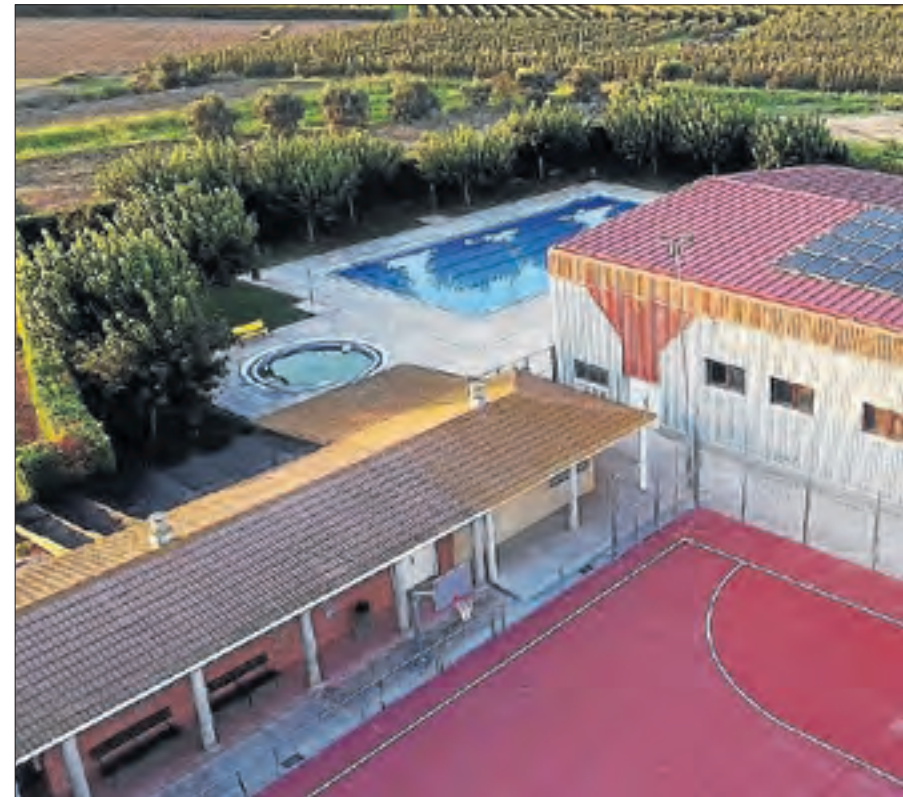
Els panells solars al poliesportiu dels Alamús també subministren energia a altres edificis.
