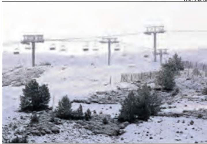
Les instal·lacions de l'estació de Port Ainé ahir.
