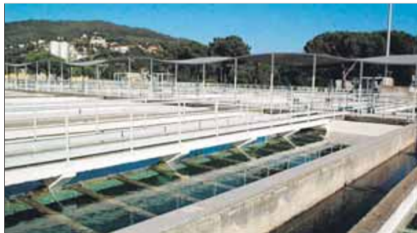
Una de les estacions de tractament d'aigua potable ■ ACN
